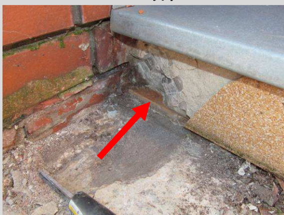
Fot. 01_9, 01_10 Murek przyścienny wykonany na powierzchni okładziny z płytek gresowych..
