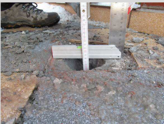
Fot. 03_6 Warstwa dociskowa – wylewka cementowa gr 8cm
