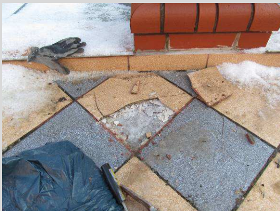
Fot. 03_3 Widok warstwy klejowej. Warstwa wykruszająca się, nienośna
