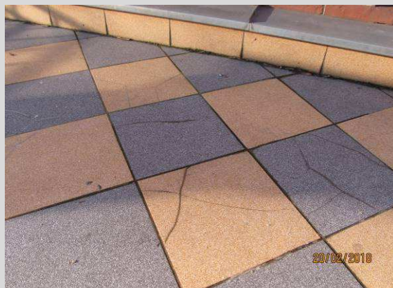
FOT_33 Widok przykładowych spękań okładziny ceramicznej.
