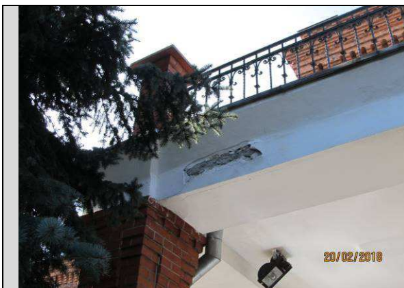
FOT_9, FOT_14 Widok przykładowych ubytków warstw tynkarskich.
