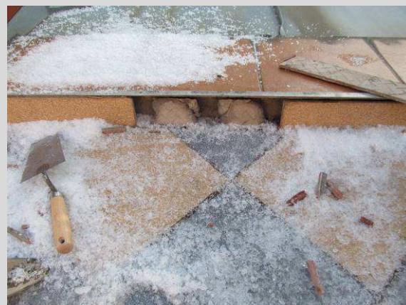
Fot. 02_2 Płytki cokołowe klejone „na placki”.
