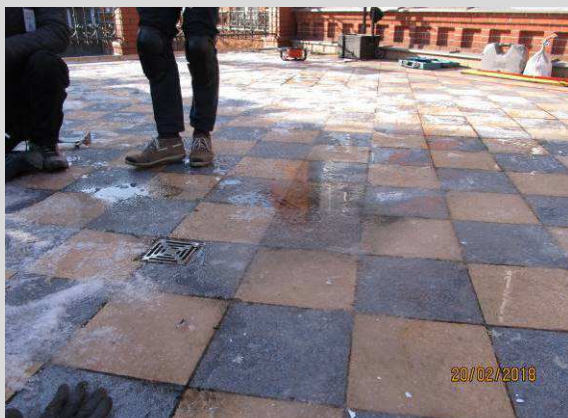
FOT_26 Widok przykładowej zastoiny wody na powierzchni tarasu.
