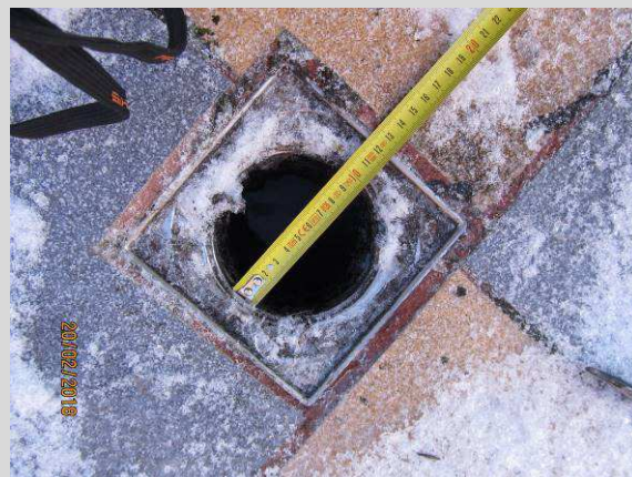
FOT_23. Wpust podłogowy Dallmer DN100.
