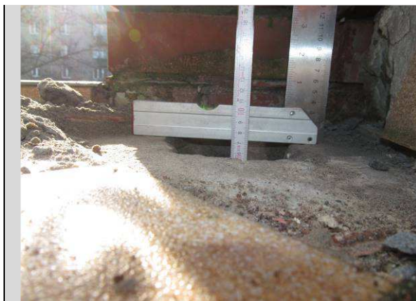
Fot. 01_11 Warstwa dociskowa – wylewka cementowa gr. 7cm.
