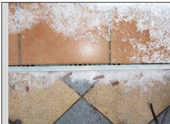
Fot. 02_3 Wykończeniowa listwa narożna zamocowana w sposób umożliwiający wnikanie wody opadowej za płytkę cokołową”.
